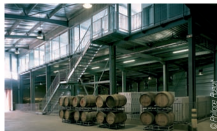
Extension de la cave coopérative d'Embres et Castelmaure (11). La structure en acier permet de moduler les différents espaces de la cave et lui donne une esthétique singulière • Anne Lacaton & Jean Philippe Vassal, architectes associés à Sylvain Menaud, architecte avec Cesma, ingénieurs structure. Constructeur métallique : CICM.
