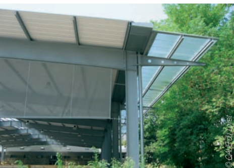
Aire couverte de 2300 m 2 toute en acier du centre équestre de Maison-Alfort (94). Le dessin de la structure et la toiture à faible pente donne à l'ensemble une allure simple et esthétique • Catherine Laroche et Pierre Volf architectes ; BIC ingénierie. Constructeur : Waltefaugle.
