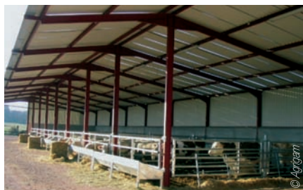
EARL du Vernay à Saint-Martin-la-Commune (71). Ce bâtiment de 580 m 2 destiné à des taurillons est réalisé en structure et enveloppe métalliques à partir de produits standards • Constructeur : Develet Frères.
