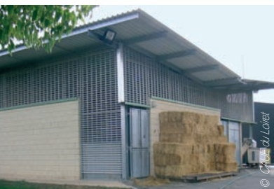
Bâtiment intercommunal des Pays d'Apt dédié aux ovins à Saint-Saturnins-Lès-Apt (84). D'une surface de 412 m 2 , il est caractérisé par un bandeau de ventelles métalliques qui « soulève » la toiture à pentes inversées • Frédéric Nicolas architecte.
