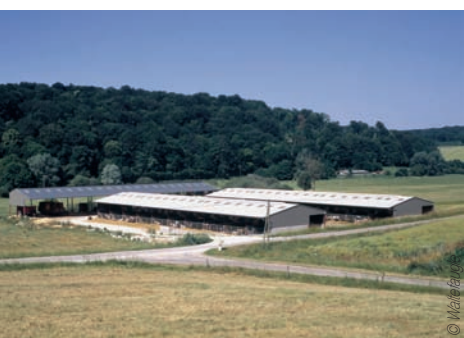
Ces granges simples de stockage agricole, implantées de plain-pied, font partie du paysage • Constructeur : Waltefaugle.
